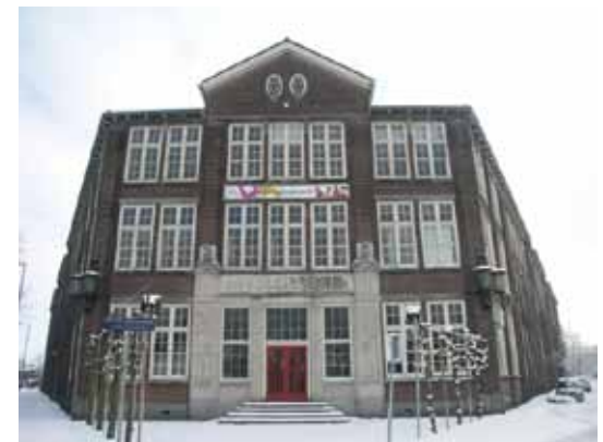
De ambachtschool, voorgevel 2011. De school is met een verdieping verhoogd en het dak aangepast. Het torentje op het dak is verdwenen (HO).
