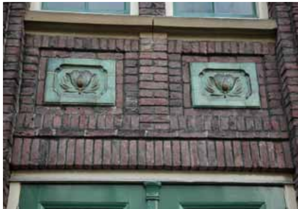
Detail tegelwerk in de gevels tussen de bouwlagen (HO).
