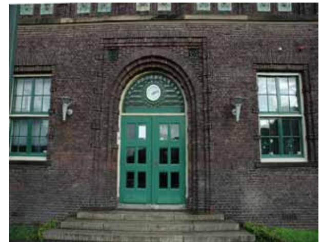
Detailopname hoofdingang (HO).
