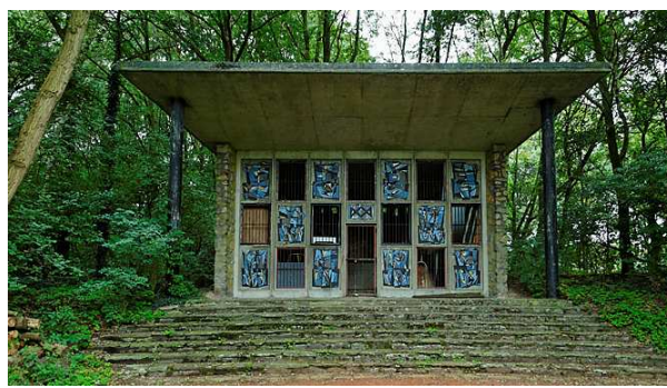
De kapel gezien vanaf de Nelissenhofweg
