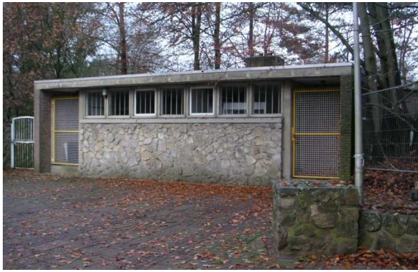
Het voormalige sanitairgebouw bij de entree
